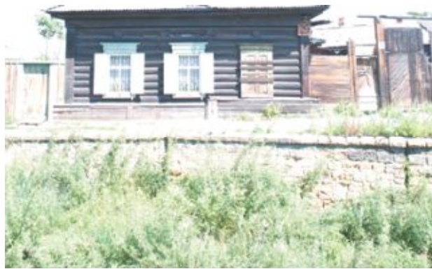
Рис. 12. Традиционный прием строительства иркутских домов с подпорной стенкой
